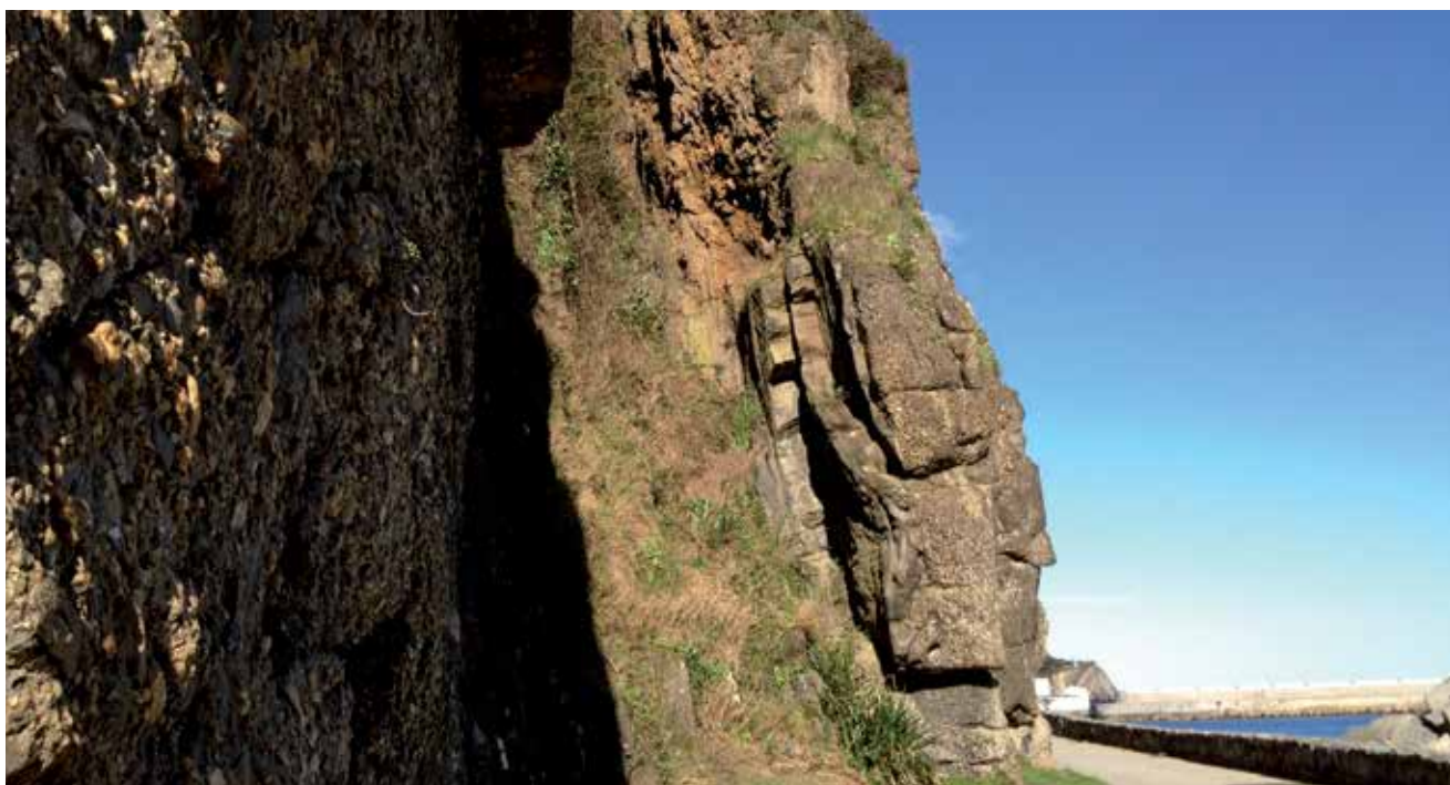
Los conglomerados de Saturraran se encuentran en el paseo de Ondarroa y se formaron como consecuencia de grandes aludes submarinos que venían del macizo de Las Landas.
